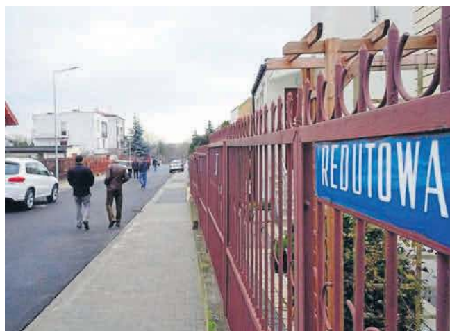
Ulica Redutowa ma 137 metrów długości. Teraz ma kanalizację deszczową i wodociąg, jezdnię z asfaltu oraz chodniki z kostki.
