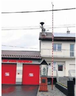
Wyremontowana remiza i ośrodek zdrowia
