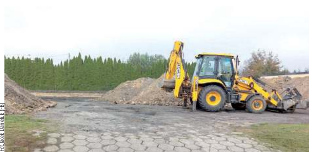
Trwają już prace ziemne przy rewitalizacji zaniedbanego terenu targowiska w Terespolu
