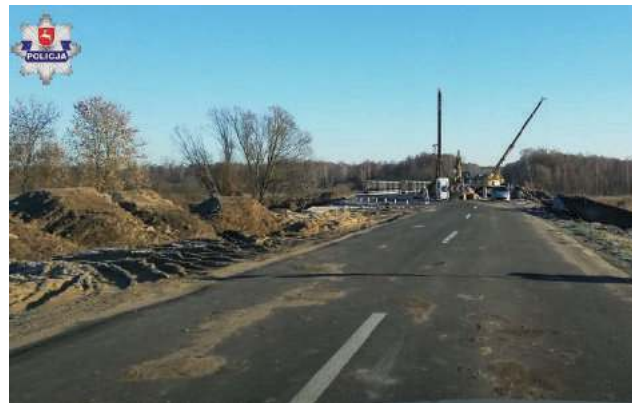
Nocą przychodził na teren budowy i niezauważony zniżał z paliwem lub sprzętem. Zdesperowany przedsiębiorca w końcu założył kamerę, która nakryła złodzieja...
