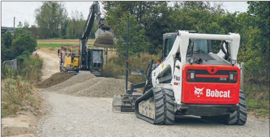
Po podpisaniu umowy z nowym wykonawcą prace na ulicy Okopowej ruszyły pełną parą. Obecnie trwa wzmocnienie nawierzchni podbudowy pod asfalt
