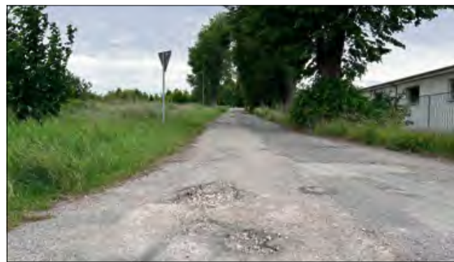
Wykonawcą zadania jest firma z Łędzin.
