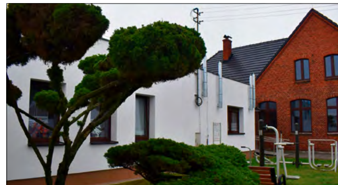
W świetlicy wiejskiej w Krzyżowej Dolinie wykonano m.in. częściowy remont elewacji.
