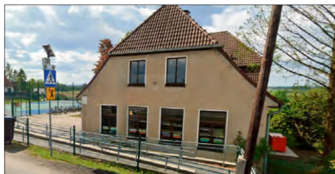
Termomodernizacja szkoły w Dańcu to przedsięwzięcie, które przyniesie wymierne korzyści.
