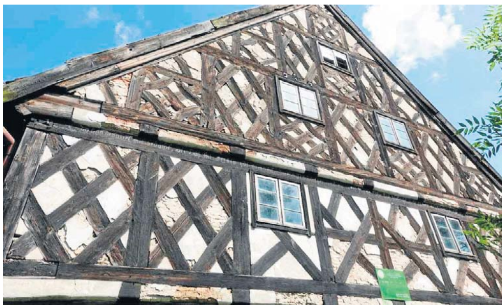
Dom ze Stalewa to konstrukcja typowa dla architektury Żuław - z murowanym przyziemem i szkieletową górną kondygnacją
