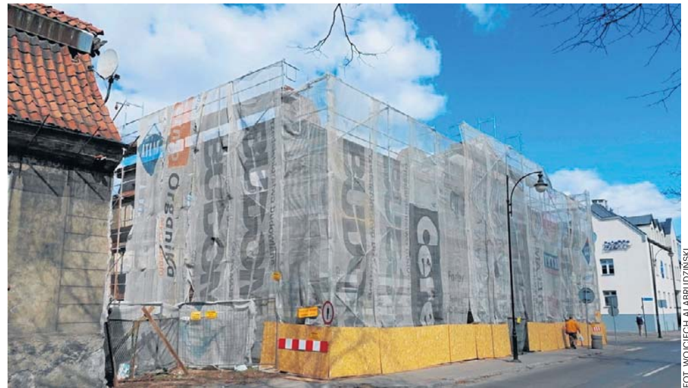
Kamienica z 1800 roku, przy ul. Królewieckiej 12, przechodzi przebudowę
