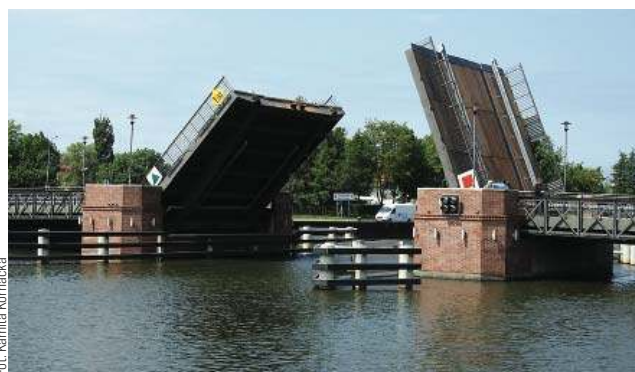
Remont Mostu Dolnego dobiegł końca
