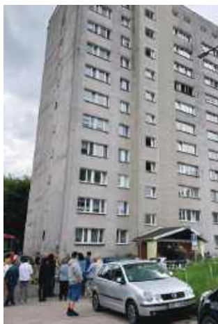
■ Mieszkańców bloku ewakuowano na zewnątrz budynku
