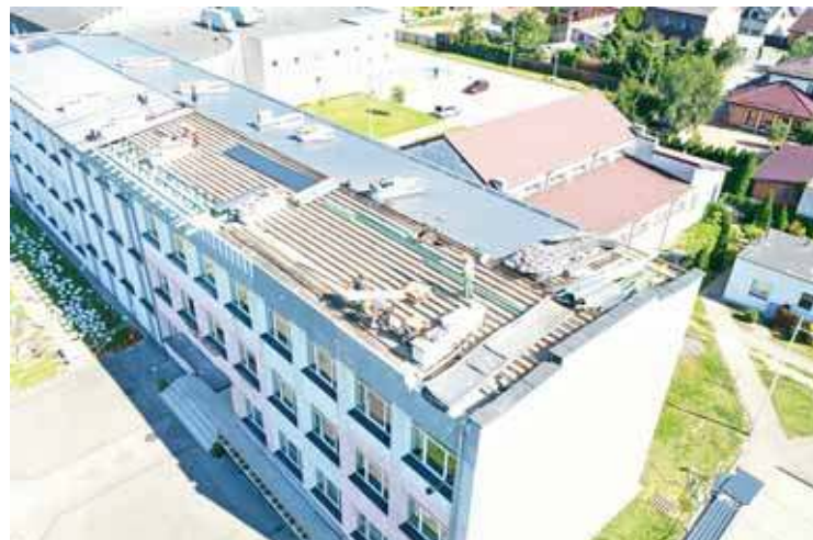
Trwają prace przy zmianie pokrycia dachowego na budynku LO im. Marii Dąbrowskiej w Żurominie.
