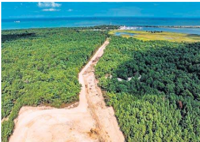
Prace na lądzie przy budowie FSRU prowadzone są w obszarze nadbrzeżnym Zatoki Gdańskiej
