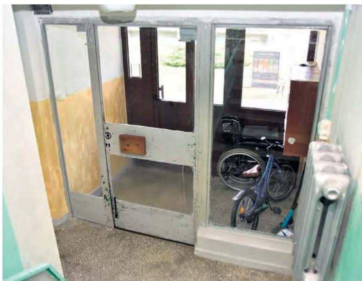
W ubiegłym roku wyremontowano wejście do klatki, a w tym mają zostać wymienione drzwi wewnętrzne.
