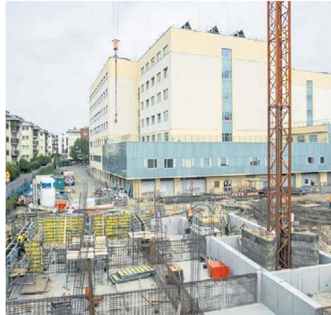
Na placu budowy trwają obecnie intensywne prace konstrukcyjne i montażowe
