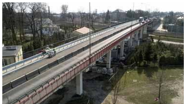
Ruch na wiadukcie przeniesiono na drugi pas
