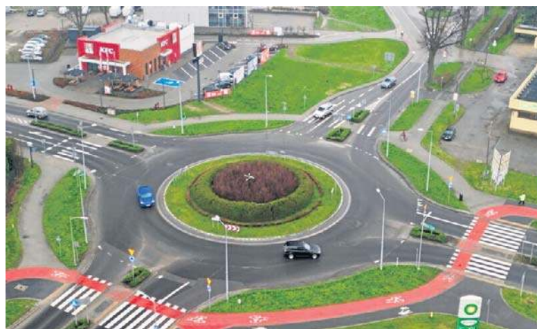
Obwodnica powstanie w ramach rządowego projektu 100 obwodnic
