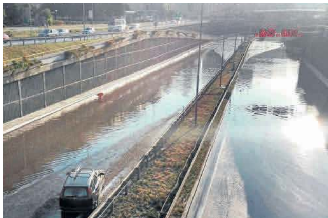
Tak w sobotę o godz. 18, cztery godziny od ulewy, wyglądał tunel
