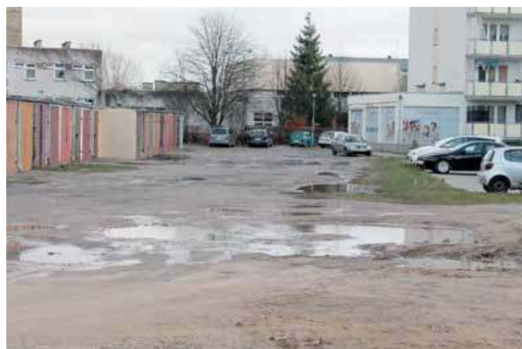
Gmina w pierwszej kolejności chce wybudować drogę w tym miejscu - jak jest tutaj teraz, widać na zdjęciu
