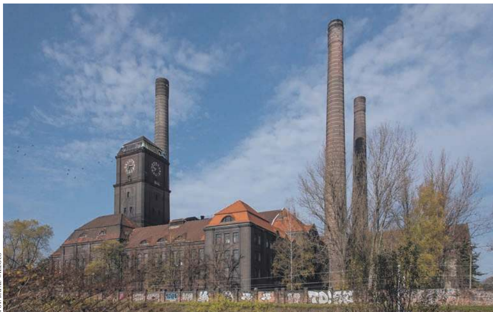
Bytomska Elektrociepłownia Szombierki
