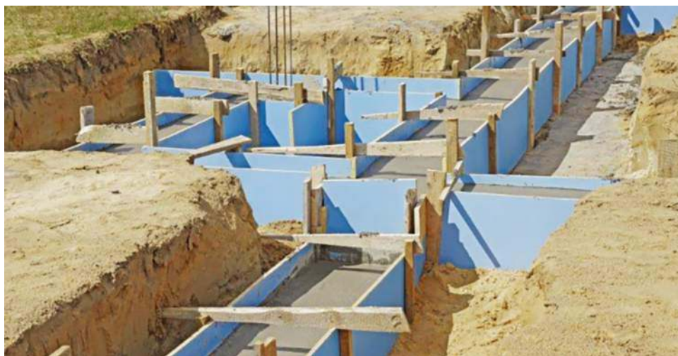
🔴 Do wykonania ław fundamentowych można zastosować drewnopodobną płytę szalunkową. PFLEIDERER
