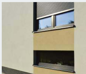
Elewacyjne rolety przytwierdzono do nadproży, które ocieplono matą termoizolacyjną.
