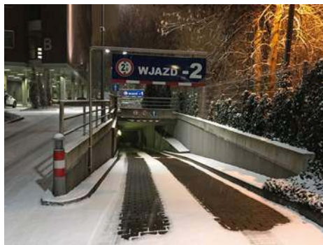
Podjazd na Cybernetyki w Warszawie. System grzewczy nVent RAYCHEM EM2-XR.
