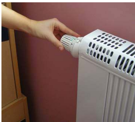
🔴 Głowice termostaticzne na grzejnikach są końcowymi elementami układu sterowania temperaturą. Nadzorują ją indywidualnie w poszczególnych wnętrzach. REGULUS-SYSTEM
