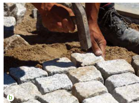
📌 Bruki klinkierowe (a LHL KLINKIER) i granitowe (b DREAMTIME) należą do najtrwalszych i bardzo dobrze znoszą obciążenia.
