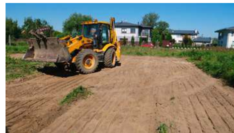
Zdjęcie humusu to początek robót, ale tak naprawdę przygotowania do budowy rozpoczynają się dużo wcześniej. A. PAPLIŃSKI
