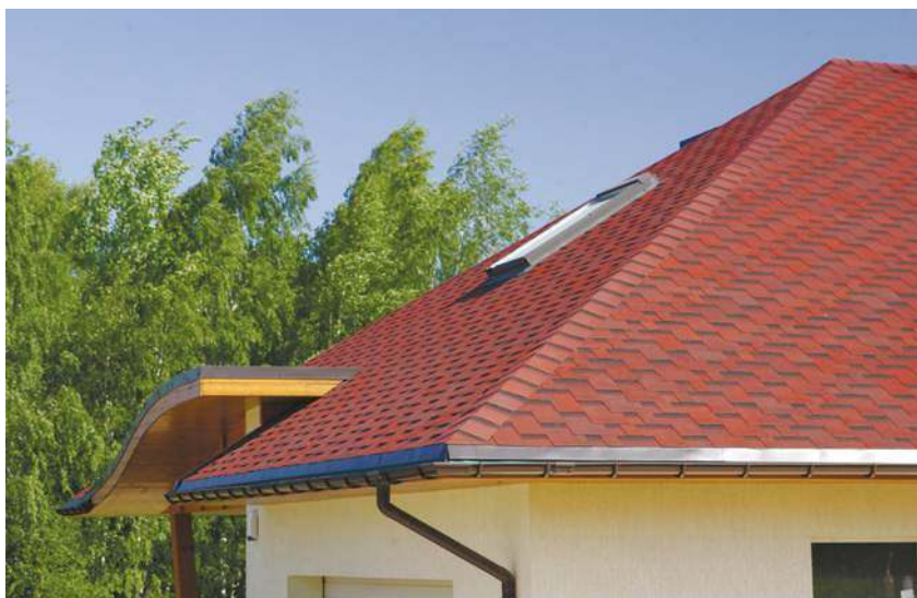
📍 Największą zaletą gontów bitumicznych jest szybki montaż oraz to, że można je układać również na dachach o skomplikowanych kształtach. TECHNICOŁ
