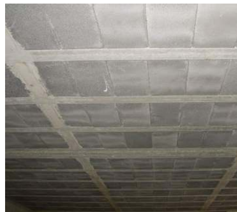
Belki nośne i żebra rozdzielcze w stropie teriva. T. RYBARCZYK
