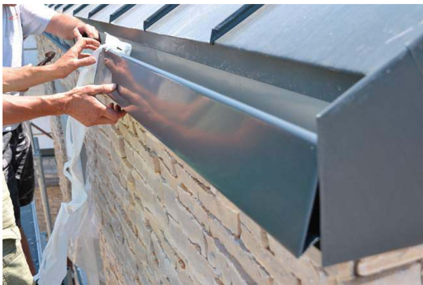
🔗 Rynny montuje się z zachowaniem ok. 0,5% spadku od najwyższego punktu do rury spustowej. GALECO
