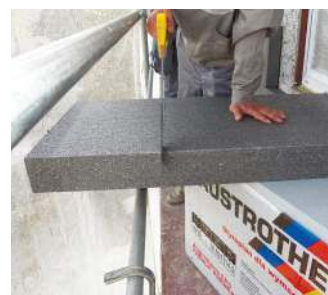
Docięcie elementów za pomocą piły ręcznej. AUSTROTHERM
