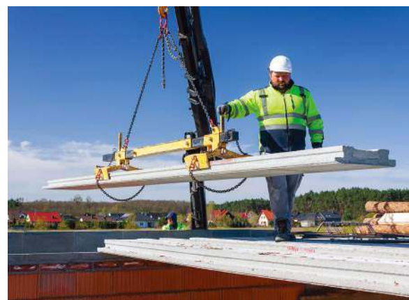
Do montażu prefabrykowanego stropu panelowego potrzebny jest dźwig. STROPY.PL
