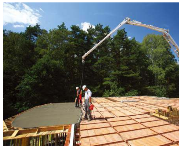
Betonowanie stropu gęstożebrowego wykonanego z gotowych prefabrykowanych elementów ceramicznych. WIENERBERGER
