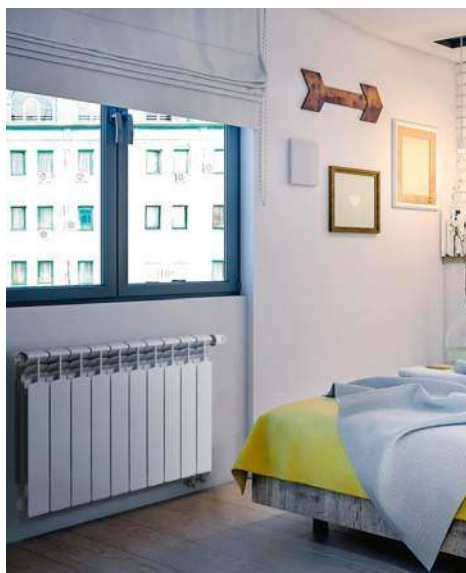
📍 Rozmieszczenie grzejników trzeba zaplanować tak, aby potem nie był zasłonięty przez meble ani inne sprzęty. KfA
