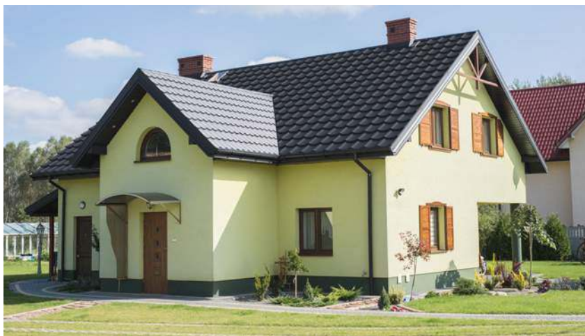
📍 Blachodachówki są jednymi z najlżejszych pokryć dachowych – 1 m 2 waży od 5 do 15 kg. BLACHY PRUSZYŃSKI
