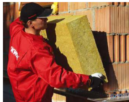
Wełna mineralna stosowana w systemach ETICS to płyty o różnej grubości o współczynniku przewodności cieplnej w przedziale 0,031–0,045 W/(m·K). ROCKWOOL
