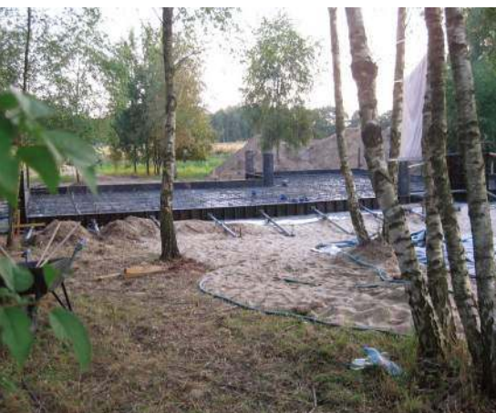
🔧 Płytę fundamentową wykonuje się pod powierzchnią całego budynku. ISOGLASS
