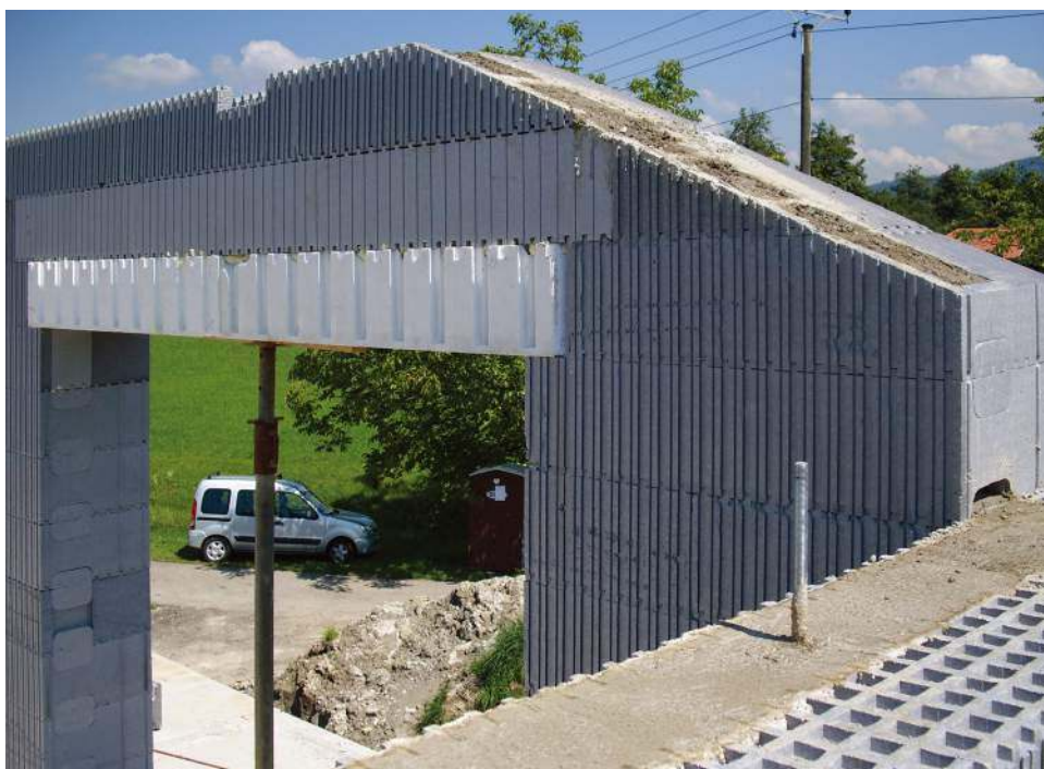
Technologia budowy domów z kształtek styropianowych daje wewnątrz betonowy trzon, który stanowi solidną konstrukcję ścian. IZODOM 2000
