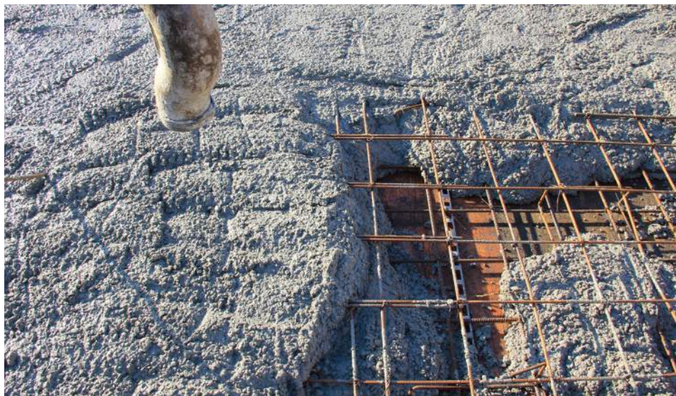
➊ Strop monolityczny to ułożone na pełnym deskowaniu zbrojenie ze stalowych prętów, które zalewa się betonem z betonowozu podawanym przez pompę. J. WERNER
