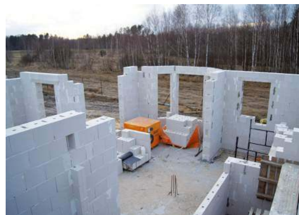
🔧 Dom budowany z pustaków wapienno-piaskowych. H+H
