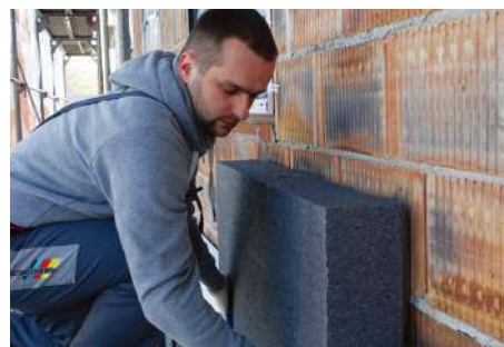
Do ocieplenia ścian można użyć styropianu z domieszką grafitu o nieco lepszych właściwościach termoizolacyjnych niż biały. AUSTROTHERM
