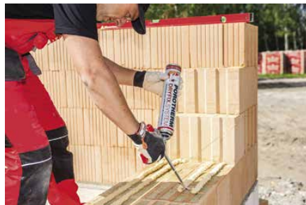
Fot. Wienerberger – nakładanie zaprawy Porotherm Dryfix
