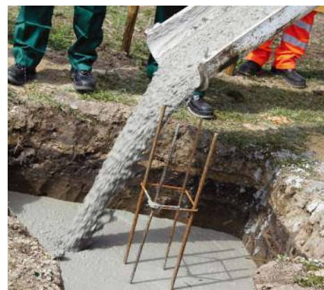
🔴 Fundamenty zalewa się odpowiednią mieszanką betonową, najwygodniej podawaną bezpośrednio z gruszki lub za pomocą pompy (jeżeli do budowy jest trudny dojazd). LAFARGE
