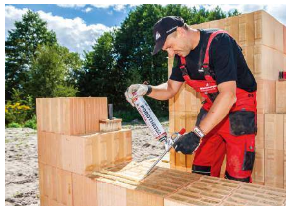
🔧 Murowanie ścian jednowarstwowych z ceramiki poryzowanej wypełnionej wełną mineralną. WIENERBERGER
