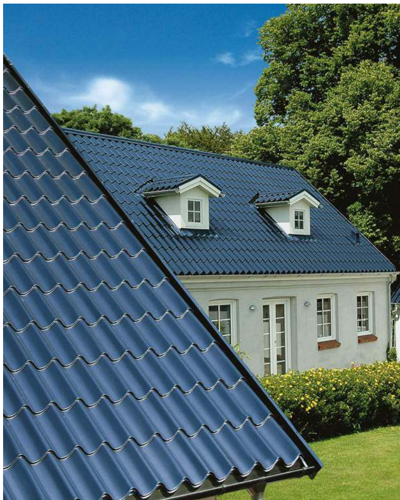
➤ Dach pokryty klasyczną blachodachówką o falistym kształcie. LINDAB
