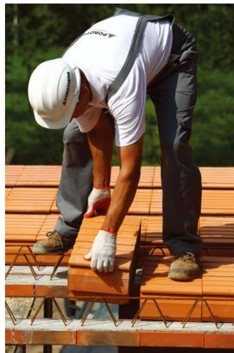
Układanie ceramicznych pustaków w stropie gęstożebrowym. WIENERBERGER
