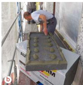
Naniesienie, za pomocą pacy, zaprawy klejowej na brzegi płyty (a) oraz punktowo w równych odległościach na całą powierzchnię (b). Płyty mają zazwyczaj wymiary 500 × 1000 mm. AUSTROTHERM
