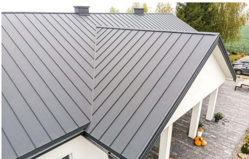
📍 Najpopularniejszy sposób łączenia arkuszy blachy dachowej to tzw. rąbek stojący. BUDMAT
