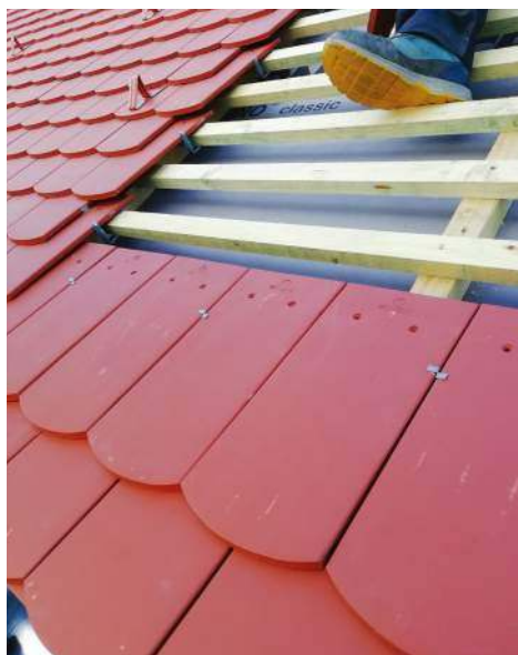
Montaż dachówek ceramicznych.
