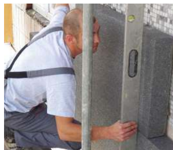
Docisnienie styropianu do ściany i sprawdzenie zachowania pionu kolejnych przyklejonych płyt. AUSTROTHERM
