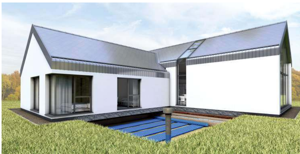
📍 Za pomocą GWC, czyli wymiennika umieszczonego w gruncie, można wstępnie podgrzać powietrze dostarczane do centrali wentylacyjnej. PRO-VENT
