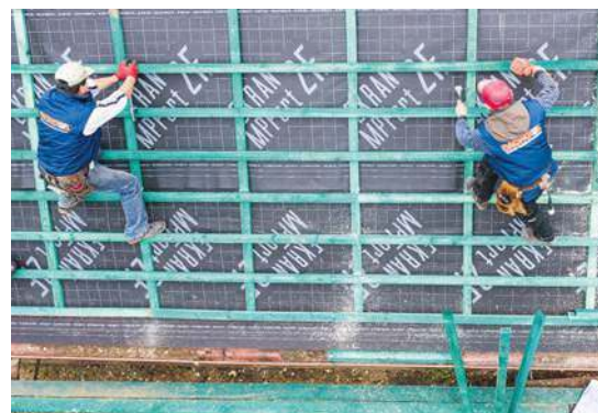
📌 Ważnym elementem każdego podkładu dachowego jest folia lub membrana, która chroni konstrukcję dachu i izolację przed ewentualnymi przeciekami. Jednocześnie stanowi zabezpieczenie przed skroplinami powstającymi pod pokryciem. MARMA POLSKIE FOLIE
