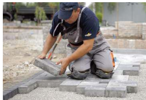
➤ Układanie kostki brukowej nie jest trudne, ale lepiej zlecić to specjalistom. Najważniejsze oprócz wybrania dobrej jakości produktów jest wykonanie solidnej podbudowy. BRUK-BET
