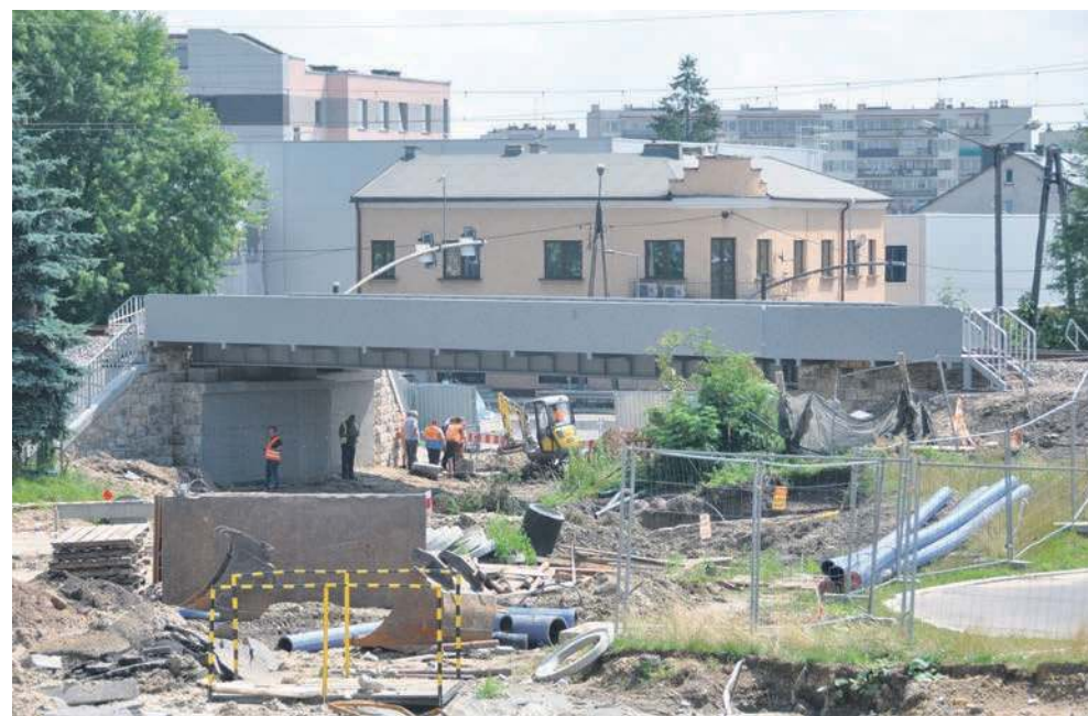
Wiadukt nad ul. Krakowską
