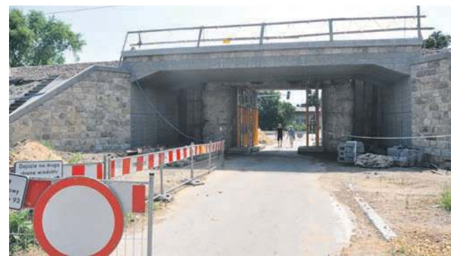
Wiadukt nad ul. Kadłubek zmodernizowany został w połowie
