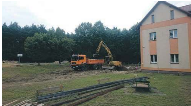
Prace przy budowie sali gimnastycznej w Jankowicach
