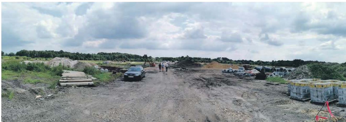
Widok na strefę ekonomiczną od strony obwodnicy Babic
