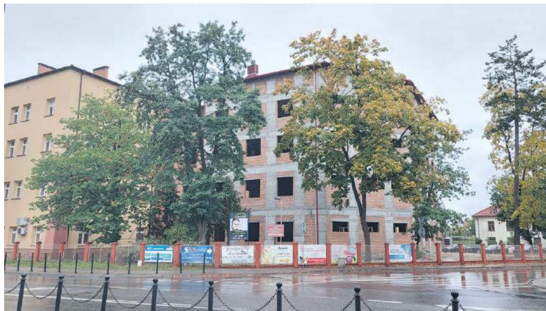
Tak w tej chwili wygląda kolejny etap rozbudowy nizańskiego szpitala
