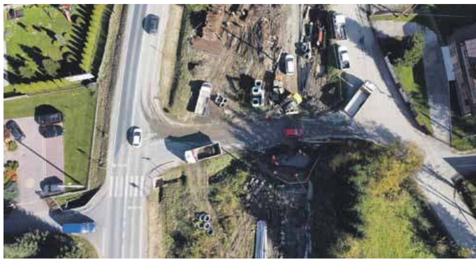
Dzięki przebudowie wąski, niebezpieczny przejazd ma zostać poszerzony do 6 metrów.
