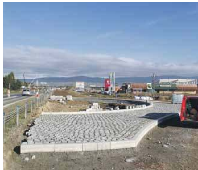
Kostka na połowie ronda już ułożona.
