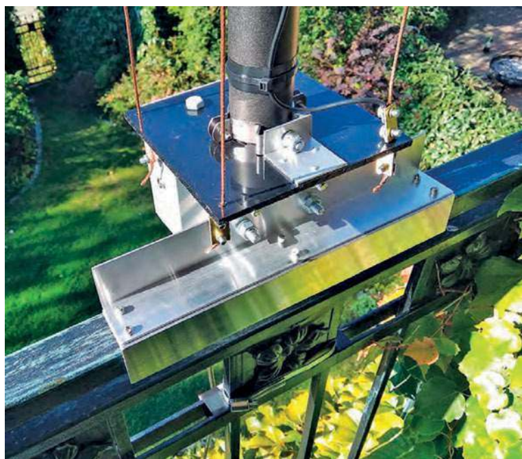
Fot. 2. Szczegóły montażu podstawy anteny i umocowania przewodów strojnika
