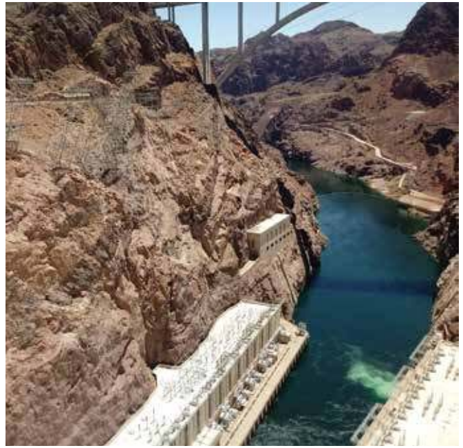
Elektrownia w zaporze Hoovera
