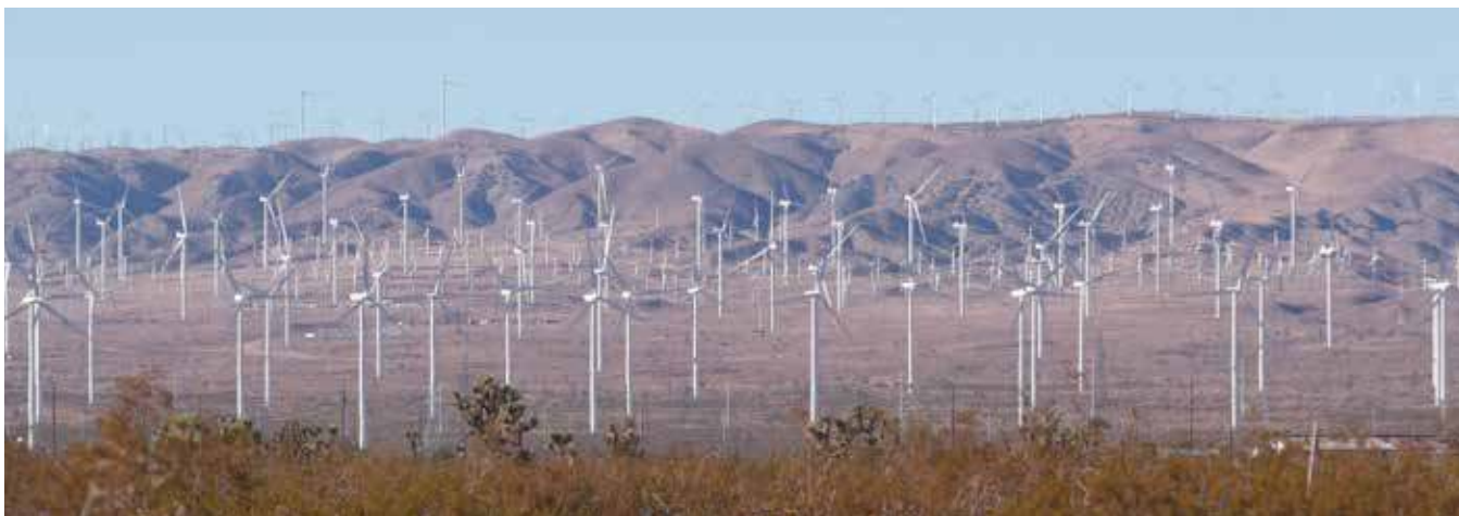
Elektrownia wiatrowa Alta, fot. Dreamstime
