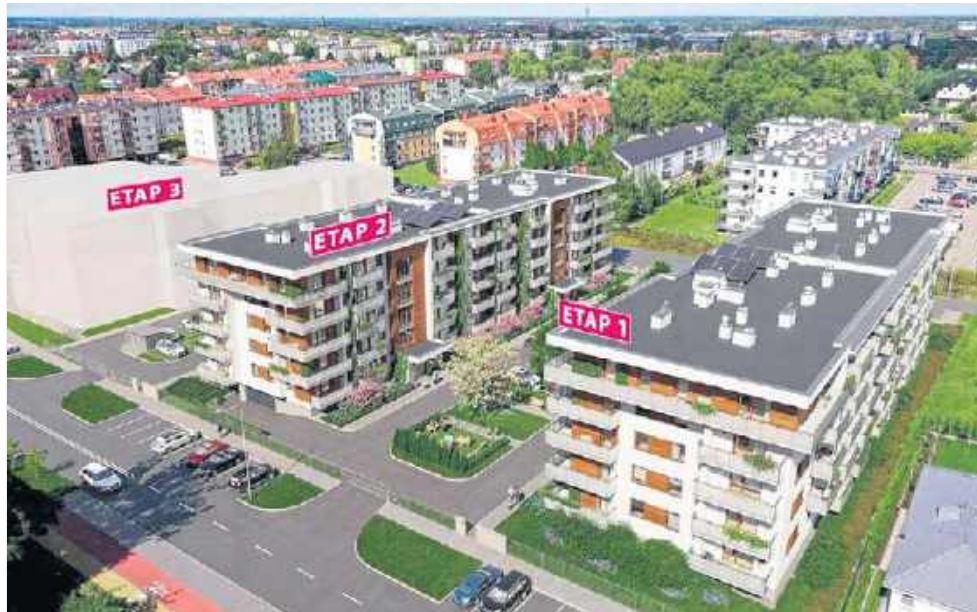
Inwestycja zakłada budowę trzech budynków mieszkalnych wielorodzinnych
