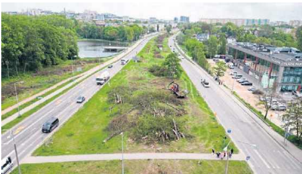
Wycinka drzew przy ulicy Łódzkiej w Kielcach. Z lotu ptaka widać rozległy teren przygotowywany pod budowę kieleckiego odcinka drogi ekspresowej S74
