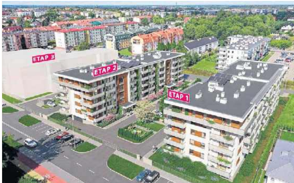
Inwestycja zakłada budowę trzech budynków mieszkalnych wielorodzinnych
