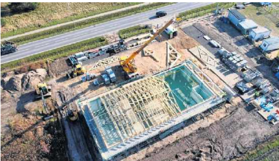
A tak wyglądała budowa Sali Królestwa Świadków Jehowy we Włoszczowie.
