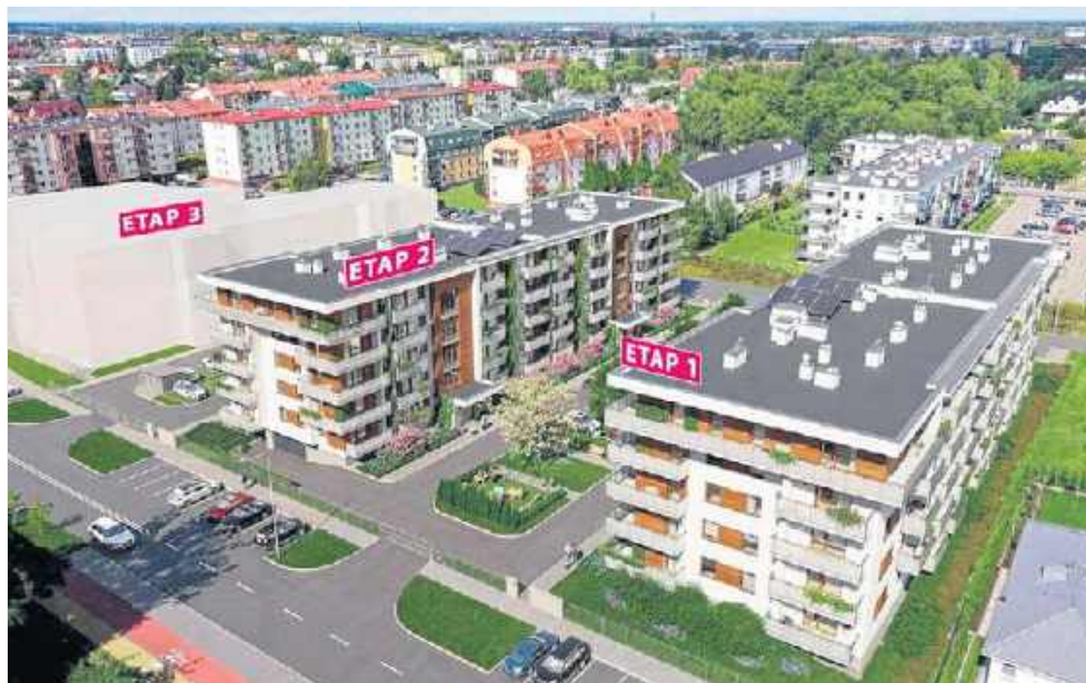
Inwestycja zakłada budowę trzech budynków mieszkalnych wielorodzinnych
