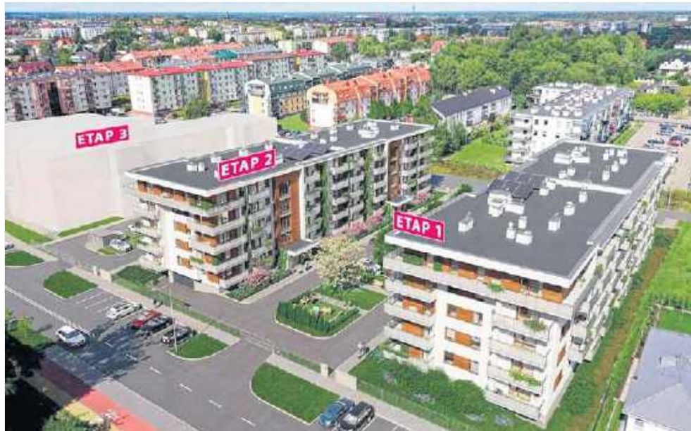
Inwestycja zakłada budowę trzech budynków mieszkalnych wielorodzinnych
