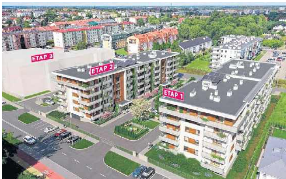
Inwestycja zakłada budowę trzech budynków mieszkalnych wielorodzinnych
