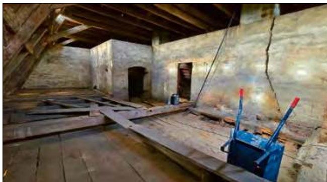
Na strychu pałacu rozpoczęły się pierwsze prace remontowe.
