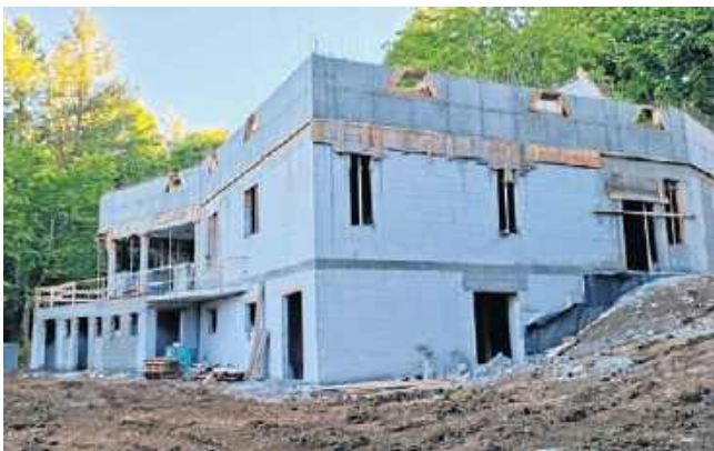
Budowa nowego schroniska na Magurze Małastowskiej
