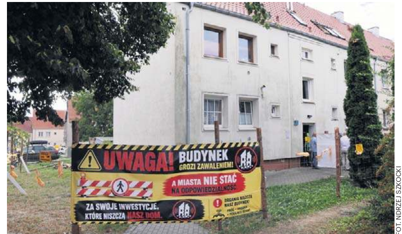
Wciąż nie wiadomo, kiedy zapadnie decyzja, czy blok z dwoma klatkami nadaje się do remontu, czy wyburzenia
