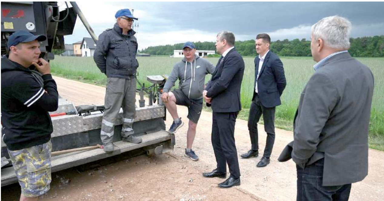
Budowa drogi od drogi krajowej numer 63 przez Sobole aż do granic powiatu radzyńskiego to jedna z najważniejszych i najdroższych tegorocznych inwestycji
