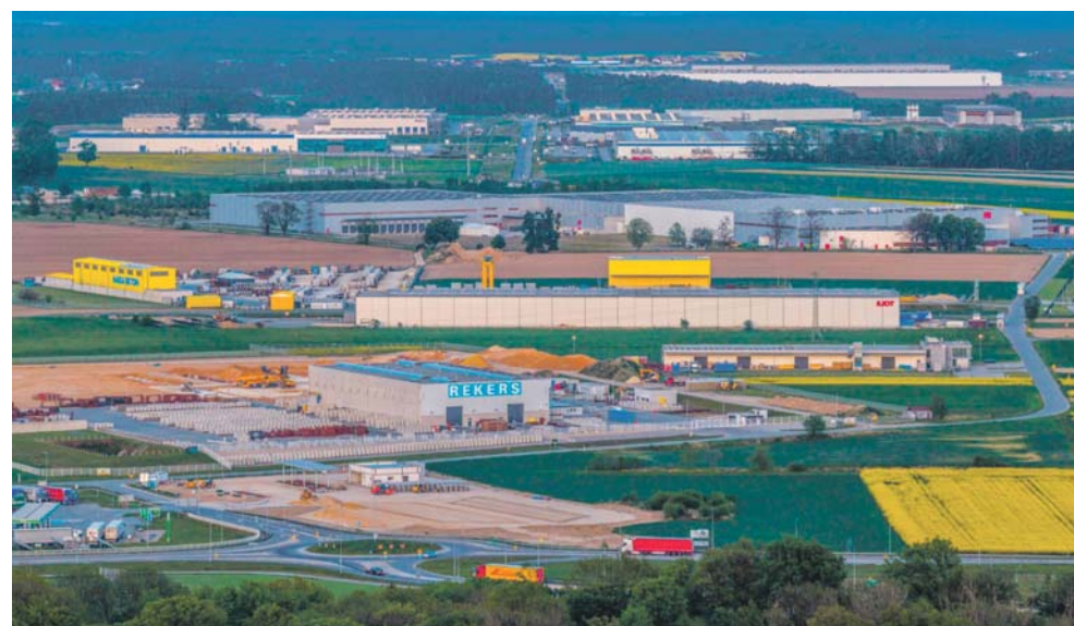
2026 Ujazd tereny SAG Olszowa widok na rondo zjazdowe z A4
