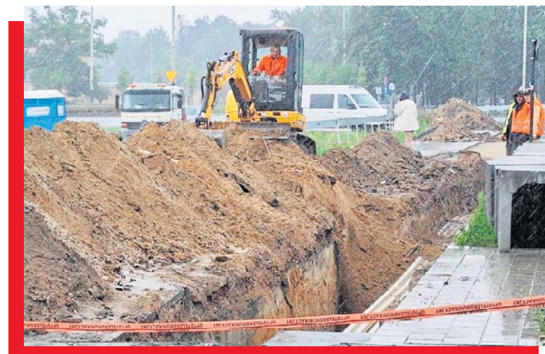
Prace ziemne na al. Bandurskiego cały czas trwają.
