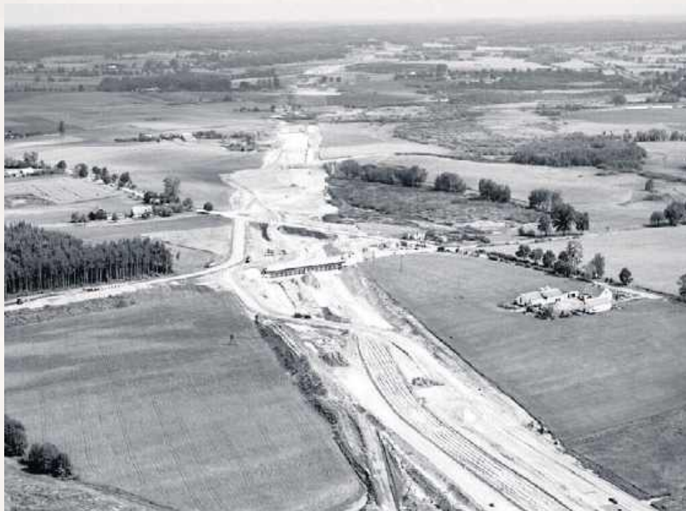
Początek budowy autostrady A1. Dziś dojedziemy nią z Gdańska do Czech w 4,5 godziny!
