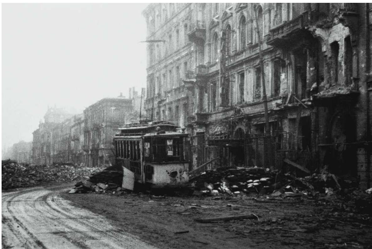
• Zniszczony tramwaj na zrujnowanej po powstaniu warszawskim ulicy Marszałkowskiej. W jej rejonie ukrywało się dużo robinsonów
