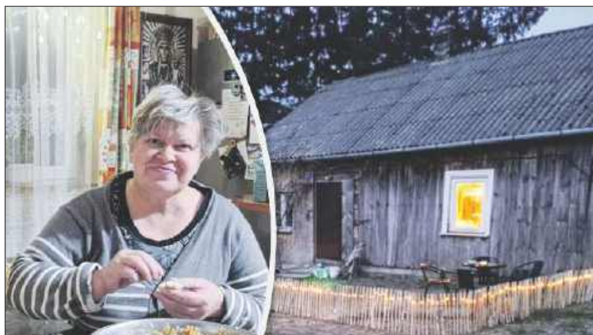
■ Pęknięta rura zniszczyła stary, drewniany dom w Górznie. Pani Barbara straciła dach nad głową i musi nocować u znajomych. Jej córka, Weronika, walczy o zakup mieszkalnego kontenera
