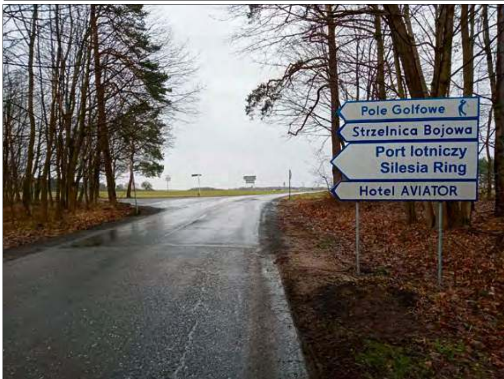
Remont drogi powiatowej nr 1817 O na odcinku Kamień Śląski granica powiatu - etap I zakończony. Na dniach rusza ostatni etap remontu.
