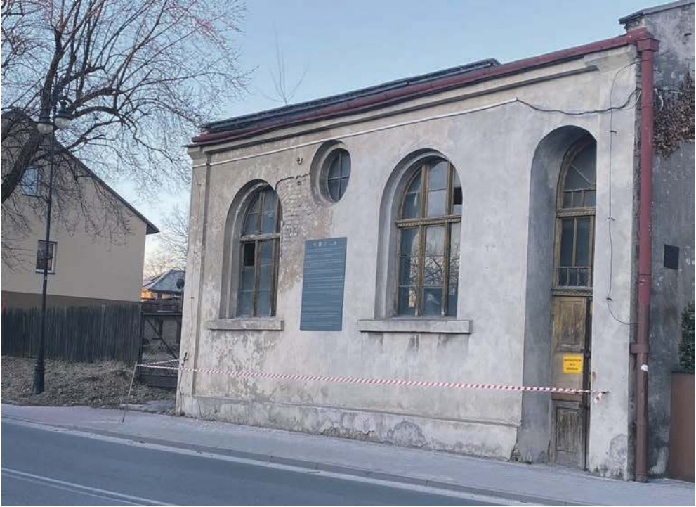
Budynek synagogi kupieckiej przy ul. Piłsudskiego 15 w Trzebinii
