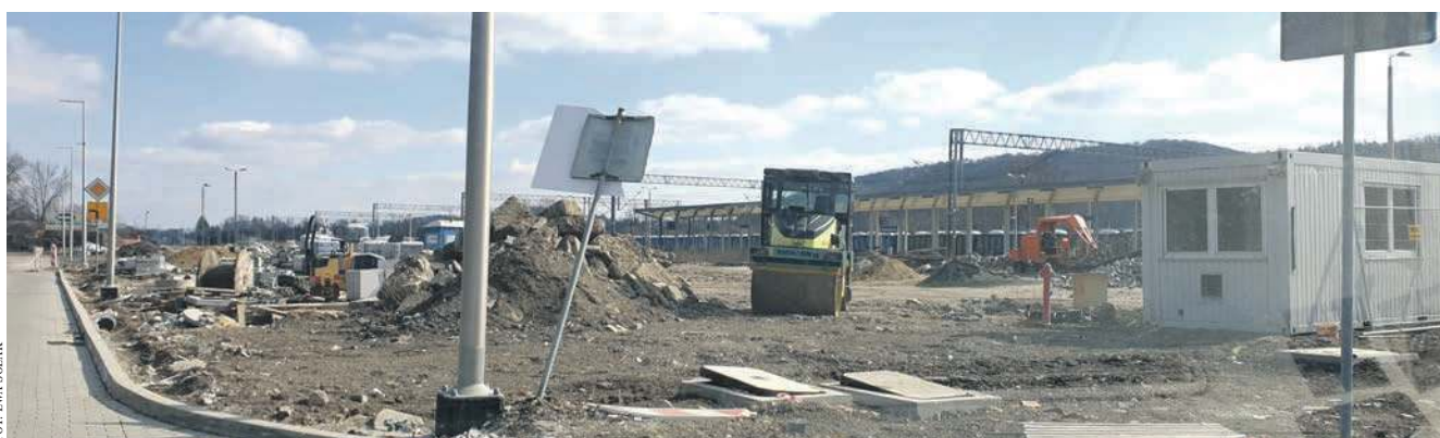
Przy dworcu PKP w Krzeszowicach trwa budowa drugiego parkingu
