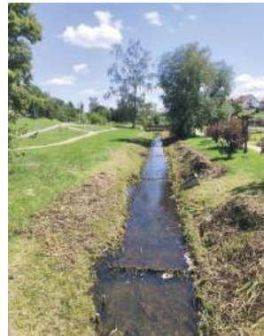
Tak wygląda zadbany kanał w jednej z miejscowości na Mazurach – brzegi są zawsze wykoszone, a spiętrzenia dłużej zatrzymują wodę w korycie.
