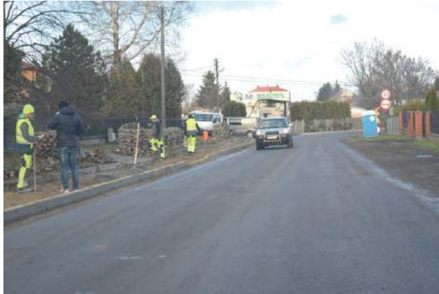
Ulica Głowackiego po zakończonym remoncie kanalizacji i położeniu na nowo asfaltu jest już gotowa. To jednak nie koniec drogowych prac w Kurowie - wójt prosi mieszkańców o cierpliwość i wyrozumiałość
