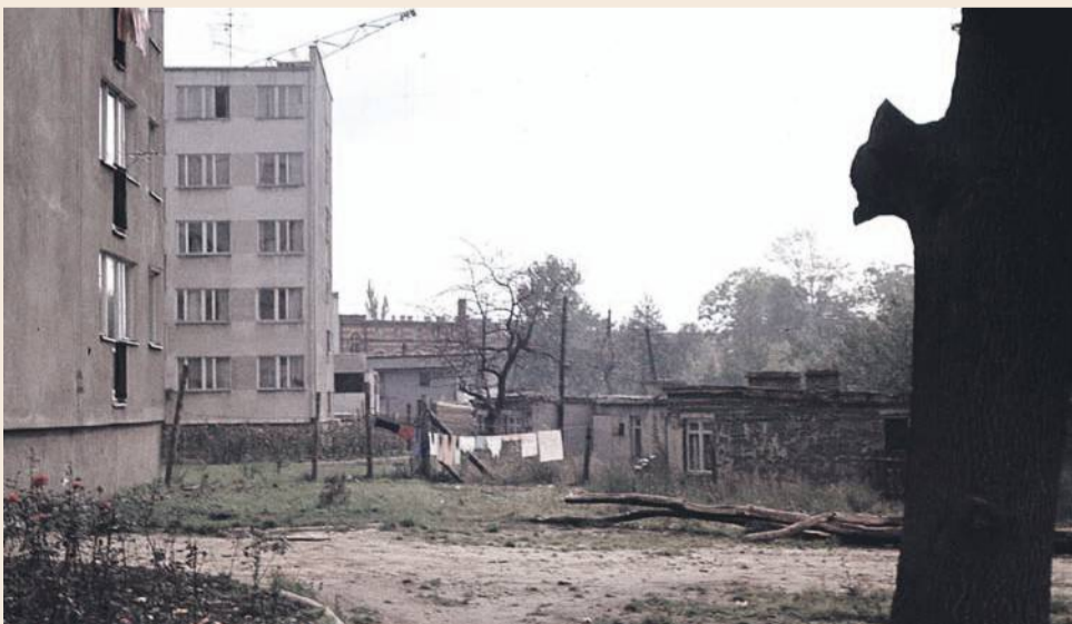
Zdjęcie nr 7 zrobił w 1972 Zbigniew Mazur w miejscu, gdzie dziś jest ulica 11 Listopada. Widoczne baraki to pozostałości po budowie bloków mieszkalnych. W głębi widać budynek, gdzie były warsztaty PKS, a na piętrze noclegownia dla kierowców PKS, później modelarnia szkutnicza SM Odra. Całkiem w głębi widać kawałek budynku Poczty Głównej
