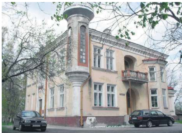
Szkoła w Niewirkowie mieści się w leciwym budynku, nad którym pieczę sprawuje konserwator zabytków. Budynek wymaga gruntownego remontu.
