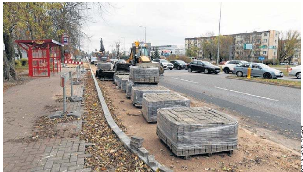
Przebudowa zatoki autobusowej przy przystanku na skrzyżowaniu Zwycięstwa i Hetmańskiej ruszyła 13 października, planowany termin zakończenia prac to 8 listopada
