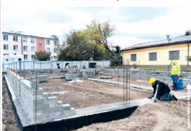
Na placu budowy widoczne są już pierwsze efekty. Budynek powstaje tuż obok obiektu, w którym obecnie funkcjonuje samorządowe przedszkole.
