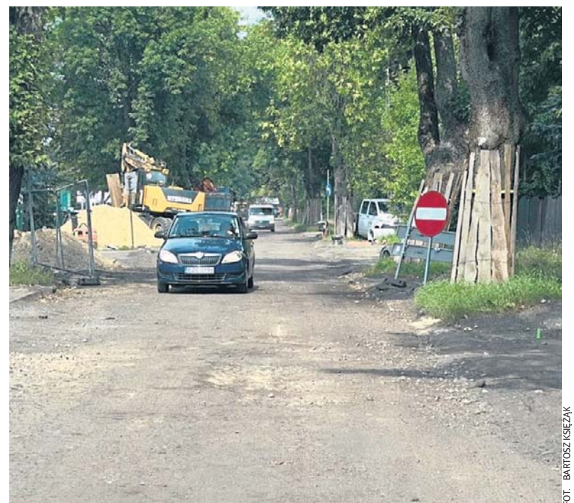
Ul. Szczecińska pozbawiona asfaltu. Za rok ma wyglądać zupełnie inaczej.
