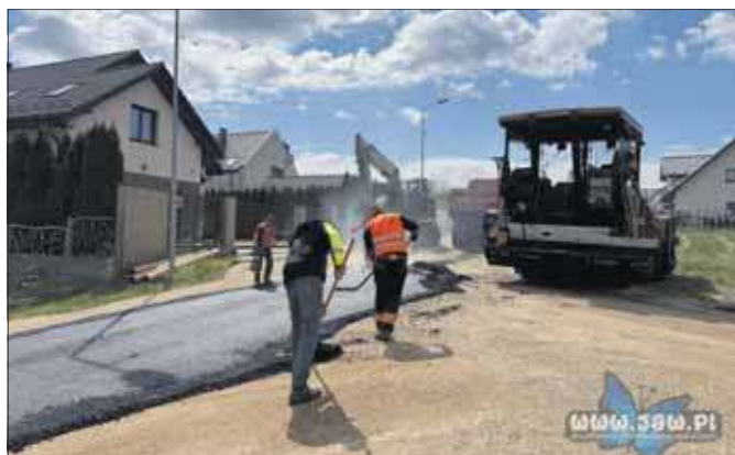
Kładą asfalt na ul. Zalipie
