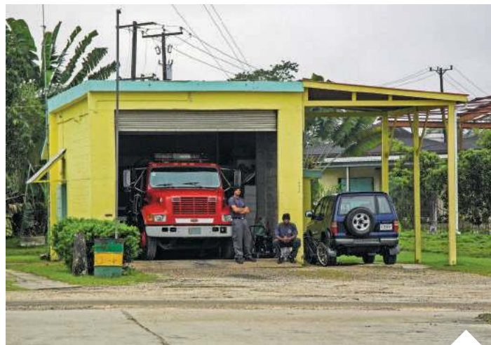
Ze względu na wilgotny klimat strażacy nie mają zbyt dużo pracy
