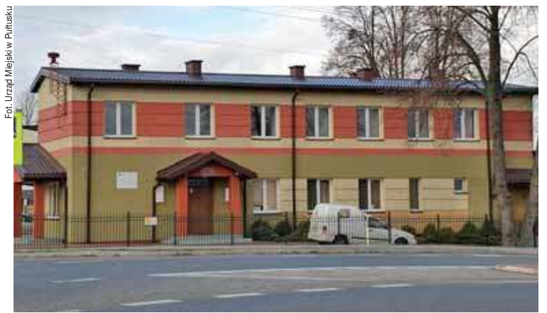
Dach świetlicy został naprawiony
