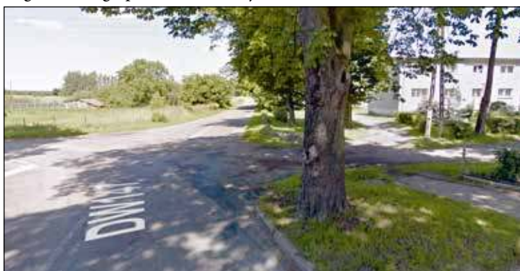
Droga powiatowa nr 4314Z Radowo Wielkie – Ługowina
