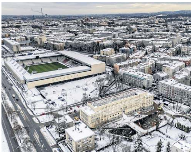
Pomysł utworzenia parku kulturowego ma związek z budową hotelu w dawnej siedzibie Miastoprojektu
