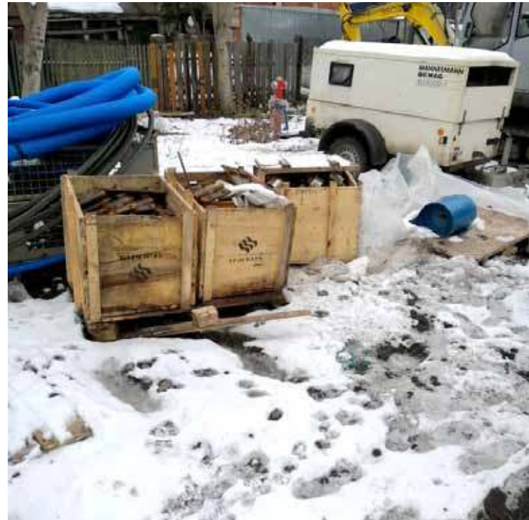
Dojście do hydrantu
