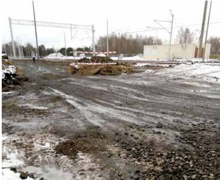
Na chwilę obecną tak wygląda plac budowy
